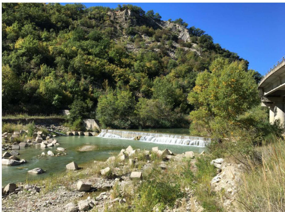
L'esistente traversa, da cui viene ricavata l'opera di presa
