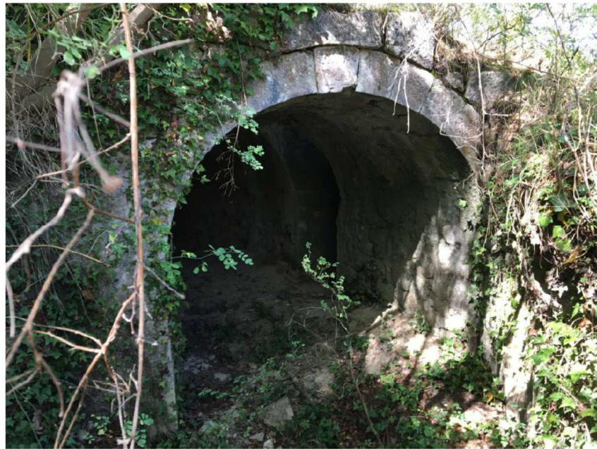
Esistente galleria (imbocco nord) che verrà riutilizzata per alloggiare la condotta, per un tratto di oltre 290 m.
