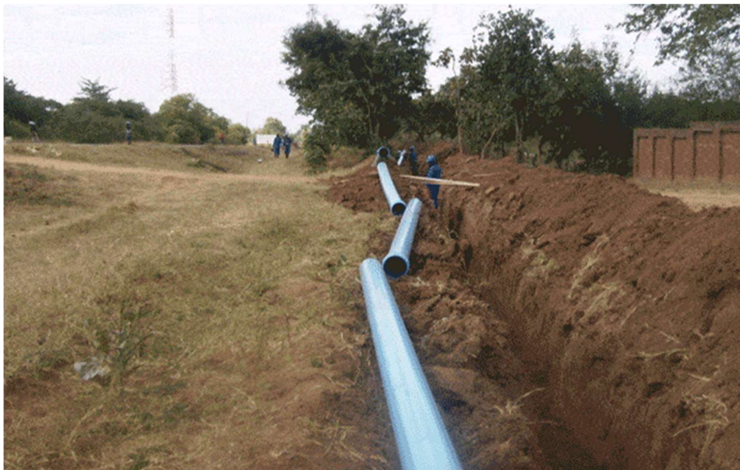
Esempio di scavo per interrimento di condotte, con accumulo laterale del terreno.
